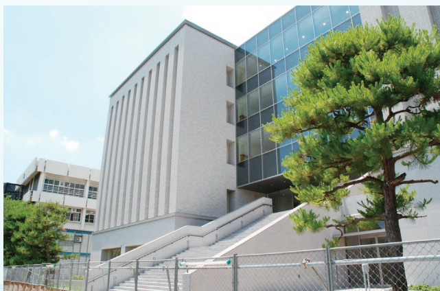
竣工間近の東棟 (2010年6月撮影)
