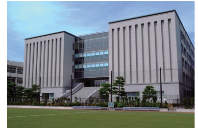
昨年8月に竣工した東棟
